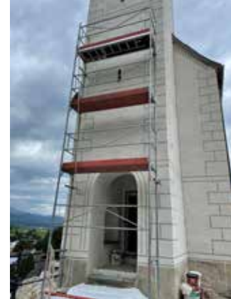
Ausbesserungsarbeiten nach Hagelschlag am Turm
